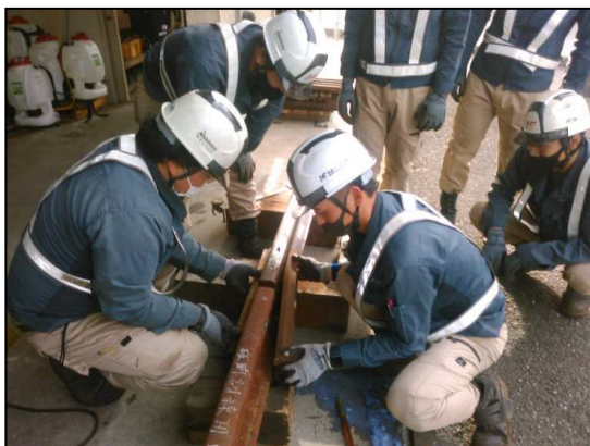
レール破断復旧訓練
