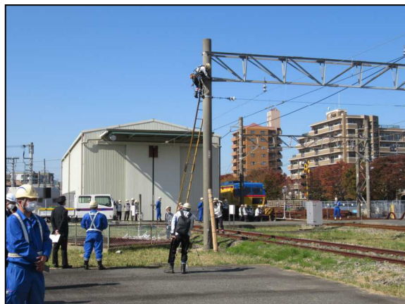
電柱傾斜復旧訓練
