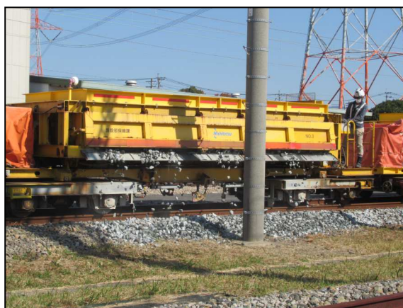
道床復旧訓練
