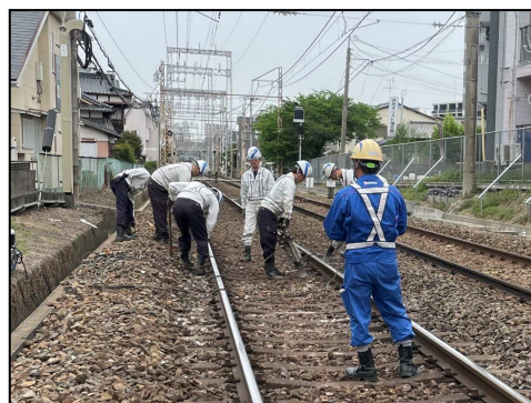
安全パトロール (作業実施状況確認)
