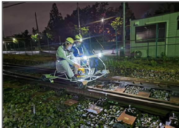
レールカートによる異常箇所点検訓練
