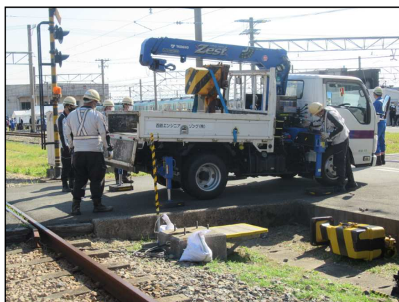
遮断機取替訓練
