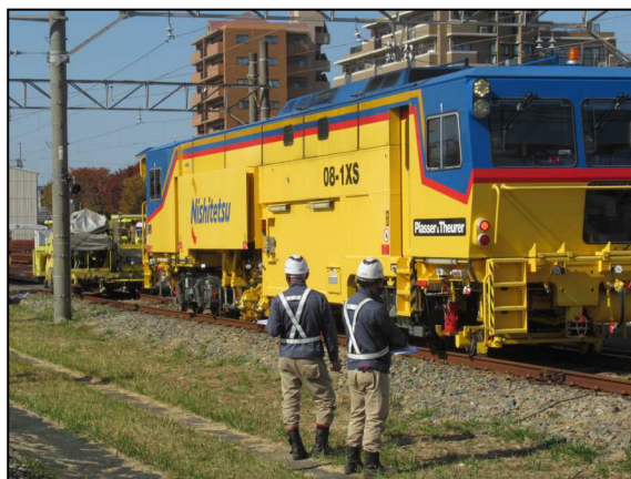
保守用車(マルタイ)による道床締め固め訓練
