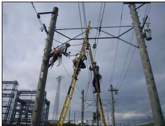
電車線断線復旧訓練
