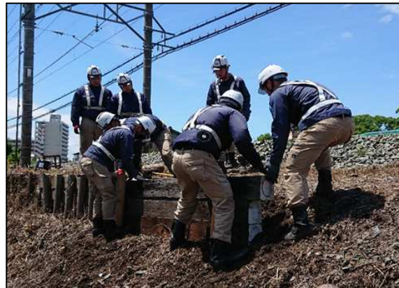
崩壊箇所の応急復旧訓練
