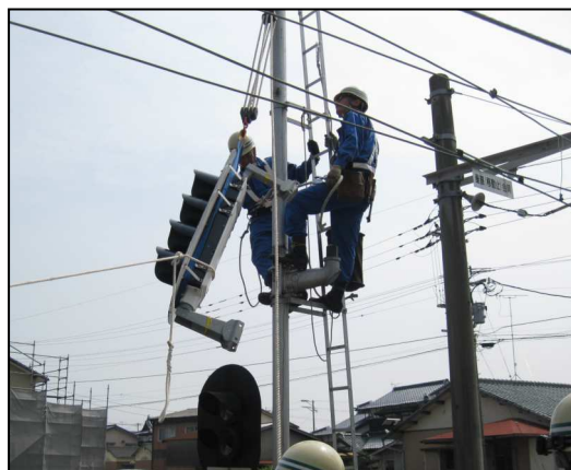
電気信号機取替訓練
