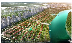
ウォーターポイント 所在地 タイニン省 種 別 分譲マンション・分譲戸建 総戸数 3,739戸・2,445戸 竣 工 2020年～
