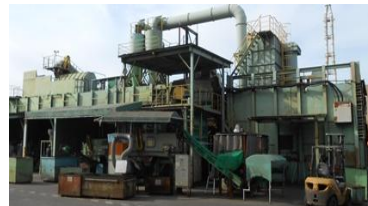
ASR再資源化施設(西鉄メタル株式会社) ※2026年4月1日付で、九州メタル産業株式会社は「西鉄メタル株式会社」へ商号を変更いたします。
