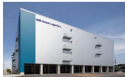
関東ロジスティクスセンター(千葉県習志野市)
