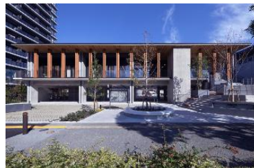
照葉北公民館・老人いこいの家 〔 竣工:2025年10月27日 施工会社:西鉄建設株式会社 〕
