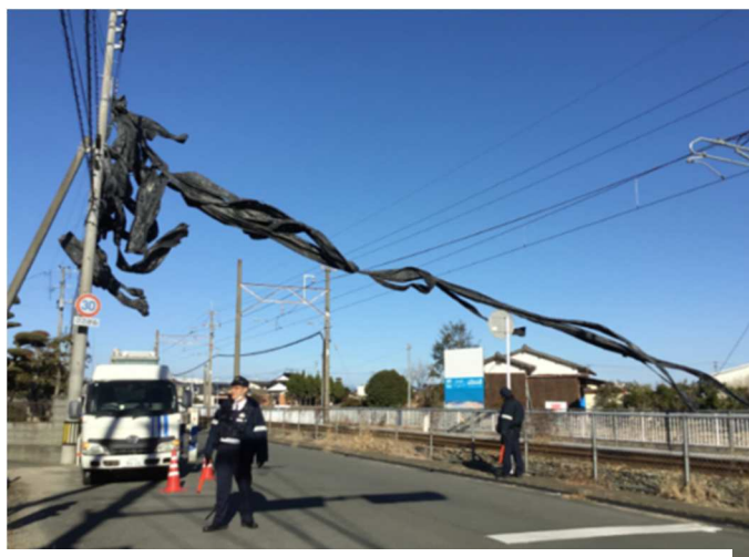
架線に絡んだビニールシート(およそ 1m×100m)
