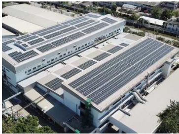
屋根上太陽光発電設備
