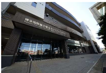
(博多国際展示場&カンファレンスセンター) 設置面積：3,232㎡ 発電容量：173kWp(DC) 年間想定発電量：200,813kWh 所在地：福岡県福岡市
