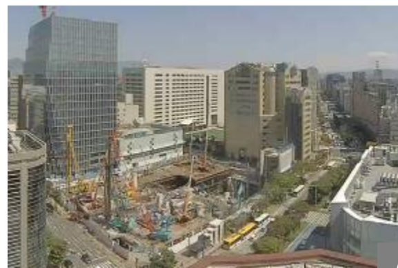
2024年度開業〔現在解体作業中〕 福ビル街区建替プロジェクト
