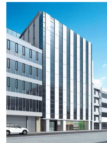
西鉄日本橋ビル
