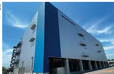
関東ロジスティクスセンター
