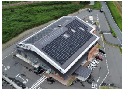
▲直方市汚泥再生処理センター
