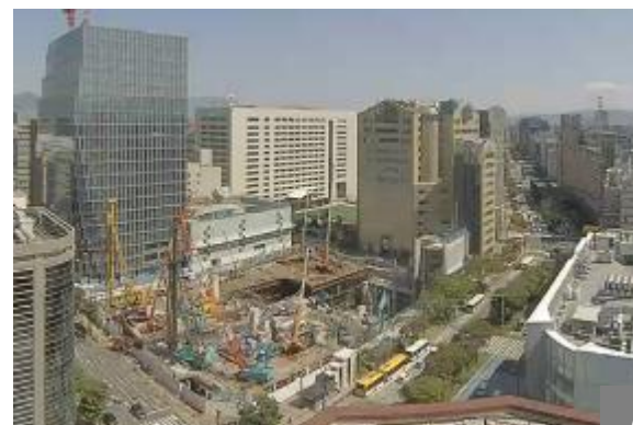
2025年春開業 ※2021.12新築工事着工 福ビル街区建替プロジェクト
