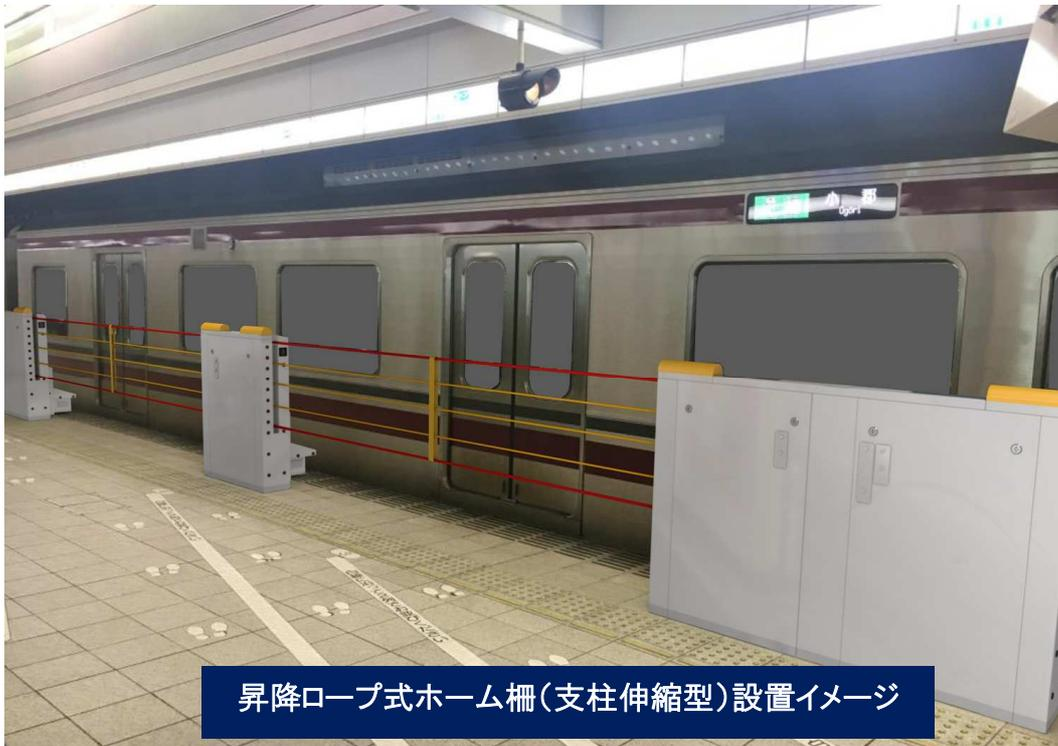
昇降ロープ式ホーム柵(支柱伸縮型)設置イメージ
