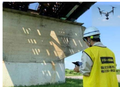
▲ドローンによる鉄道施設点検
