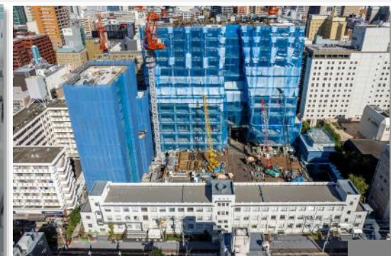
▲工事進捗(2021.10時点)
