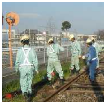
まくら木交換作業 (線路関係)
