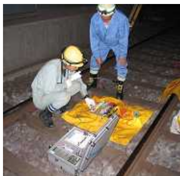
ケーブル検査作業 (電気関係)
