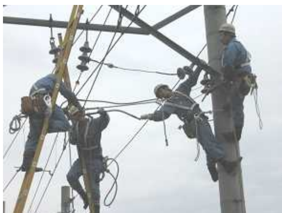
電気部門による架線復旧訓練
