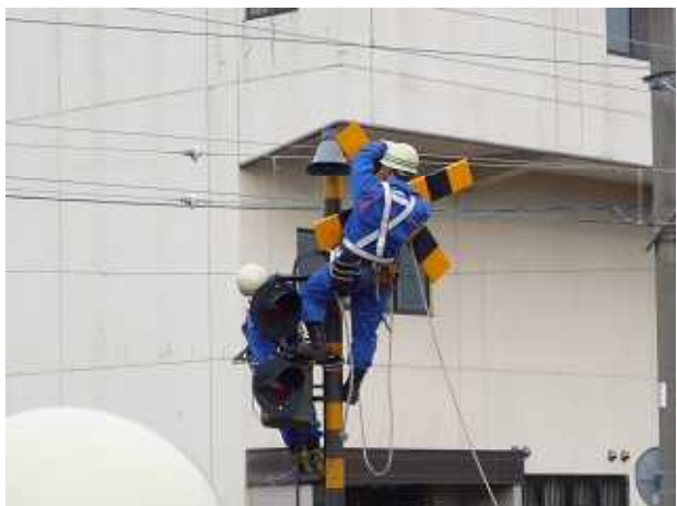
踏切警報機柱復旧訓練
