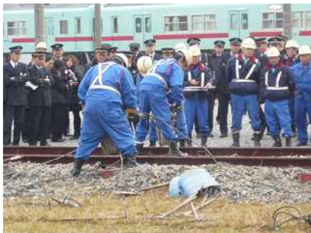
枕木復旧訓練
